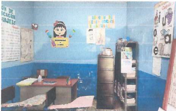
Foto1: Reparación de repello y cernida de paredes.
