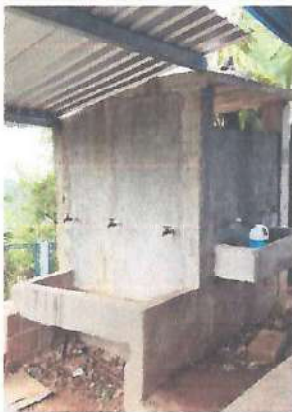
Foto 3: Reparación del sistema de agua potable
